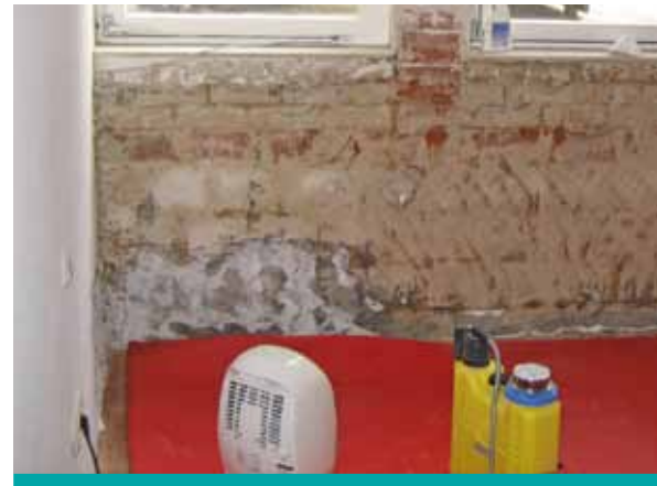
Zustand nach Abschlagen des Putzes
